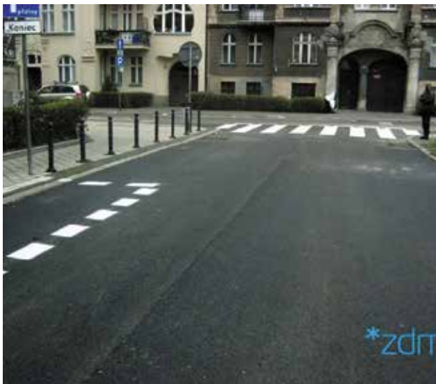
Ul. Asnyka po remoncie, fot. ZDM
